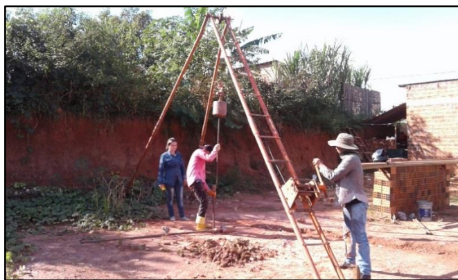
Figura 43 Ejecución del Ensayo SPT
