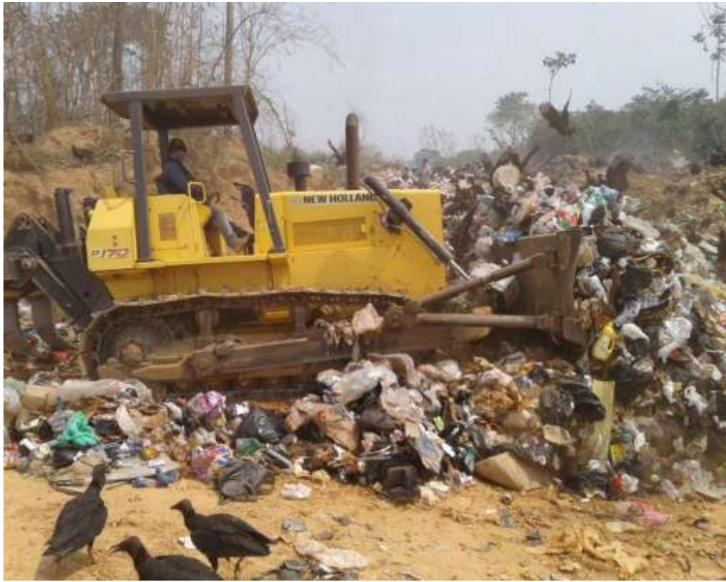
Mostrario fotográfico de la maquinaria compactando la basura en el relleno sanitario del Servicio Municipal de Aseo Urbano
