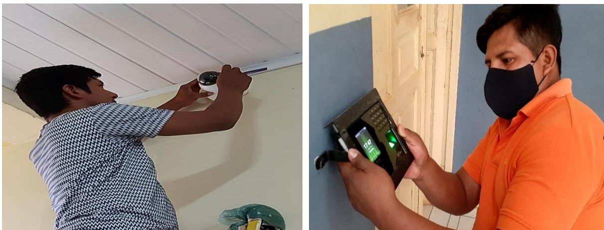
Ilustración 3.24 Posicionamiento de Cámaras IP y Biométrico
