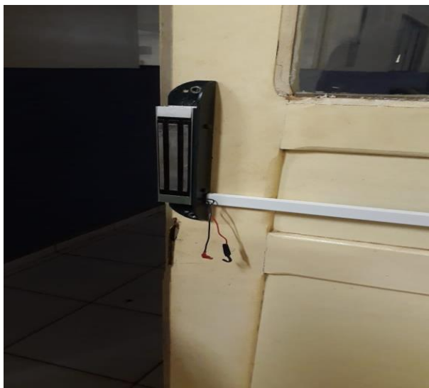
Ilustración 3.27 Instalación de cerraduras electromagnéticas
