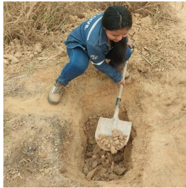
Imagen 19 Excavación de calicatas
