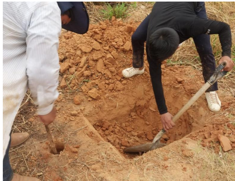
Imagen 24 excavacion de calicata
