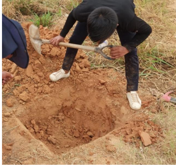
Imagen 8 Excavación de calicata
