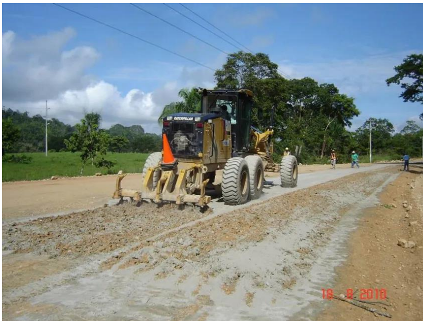
Imagen 10 Mejoramiento de suelo con cemento
