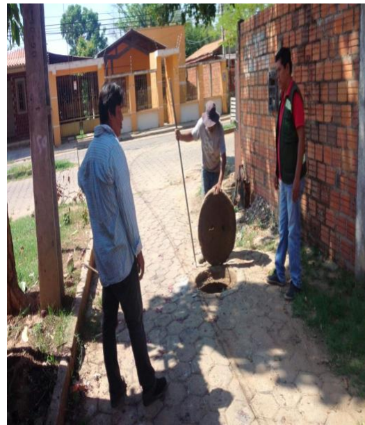
Foto N°8 Limpieza de Canales Pluviales
