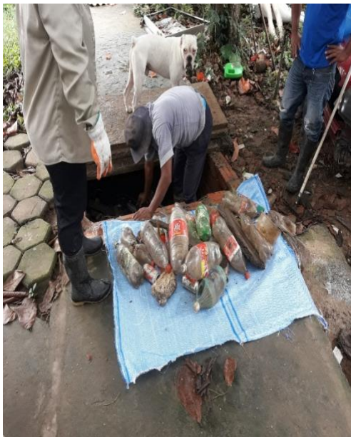
Foto N°7 Limpieza de Sistema de Alcantarillado
