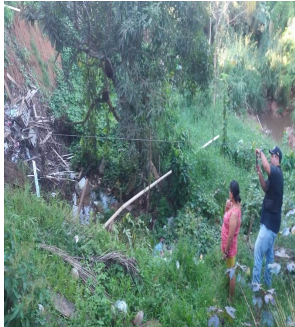
Foto N°4 Afectan el aguas lluvia está erosionando
