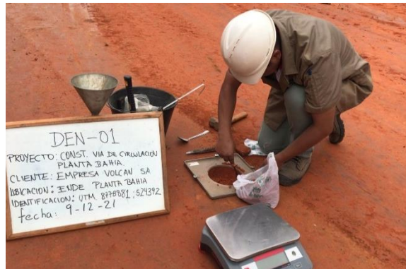
Figura 96. Excavación de hoyo
