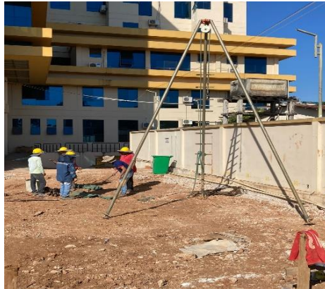
Figura 107. Armado de equipo de SPT.
