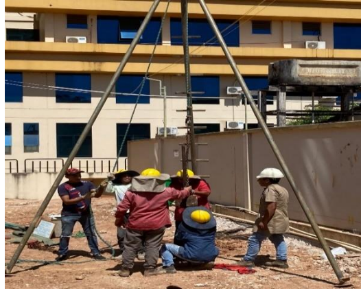
Figura 110. Retiro de martillo después de penetración de 450 mm.
