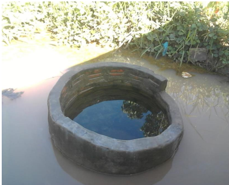
Noria recubierta de ladrillo y fuente de agua limpia Fotografía mediante celular-comunidad villa Fátima
