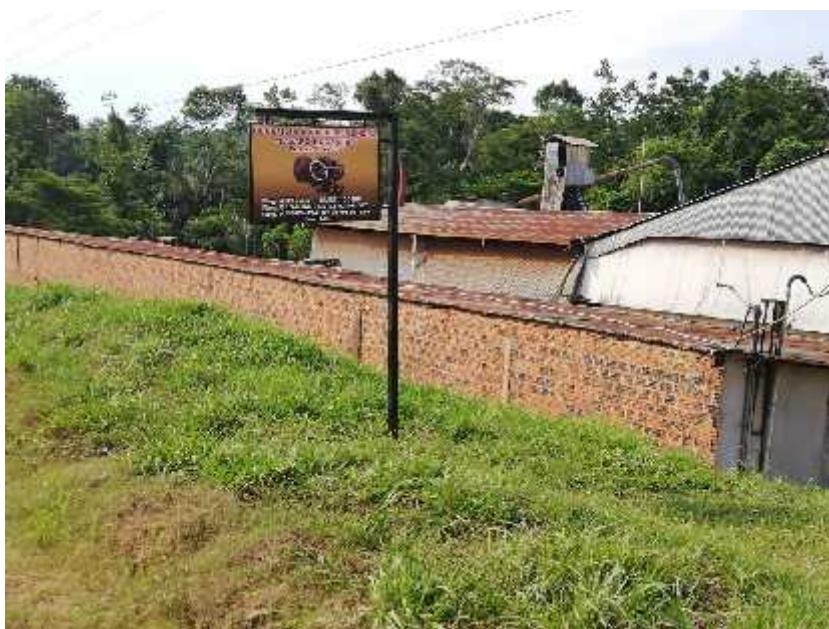
Figura 10. Instalaciones de la beneficiadora de almendra “Favaro Hnos. Srl.”
