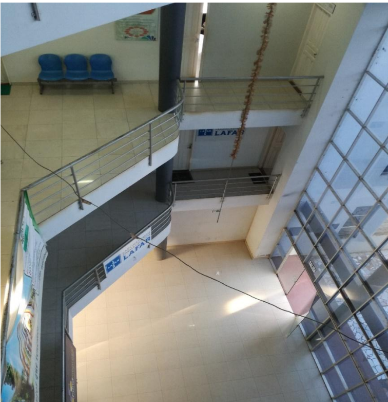
Figura 12 Vista interior CICPANDO Fuente: Elaboración propia
