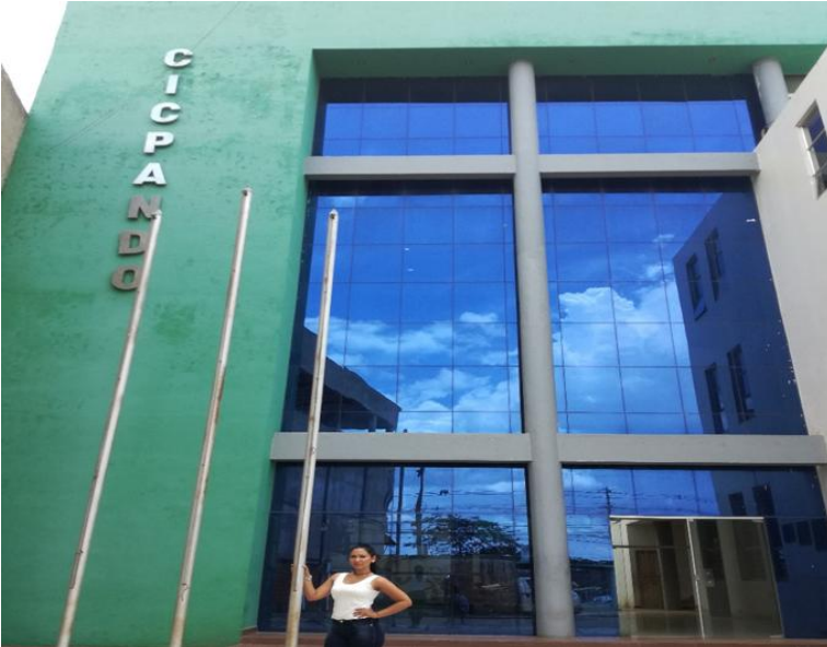
Figura 11 Vista exterior CICPANDO Fuente: Elaboración propia
