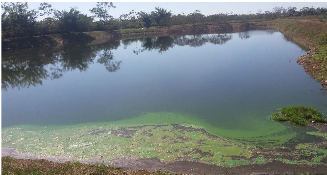
Figura 13. Fotografía de la laguna anaeróbica de la P.T.A.R
