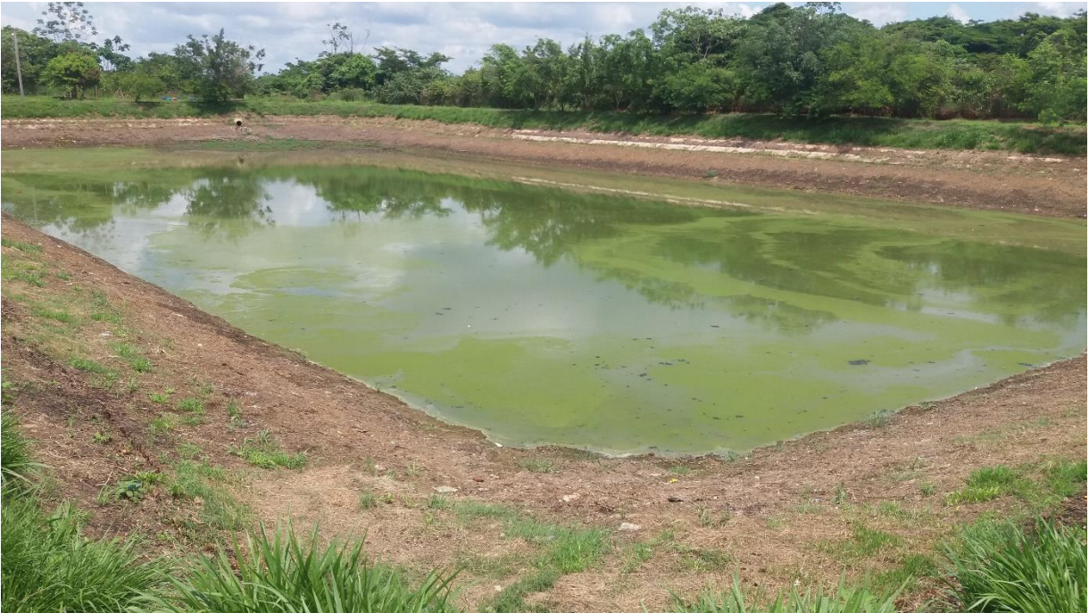
Fotografía 6 Laguna Anaeróbica de la PTAR
