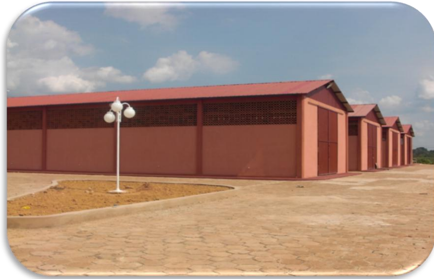
Instalaciones de Zofra Cobija, Parque Industrial Amazónico (PIA)
