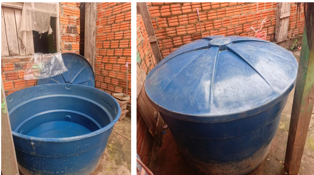
Figura 6. Almacenamiento de agua tanque tapado y destapado
