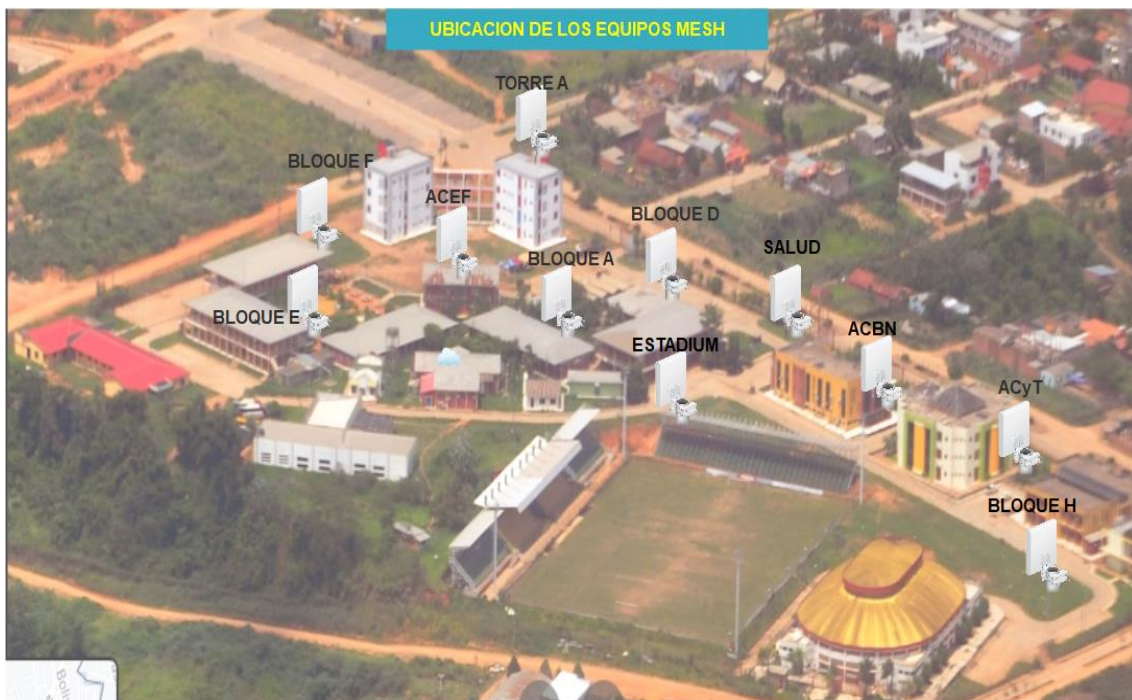
Figura 29: Ubicación de los equipos
