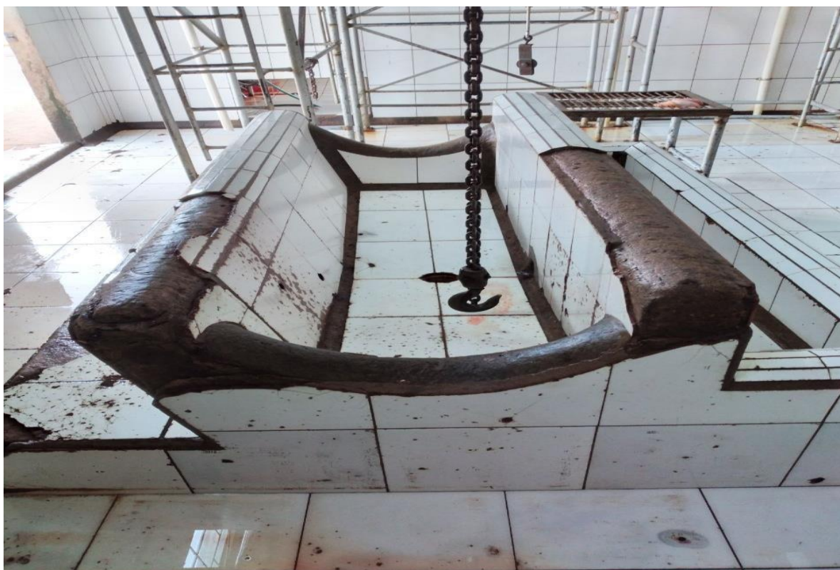
Instalaciones internas del matadero Floresta S.R.L.
