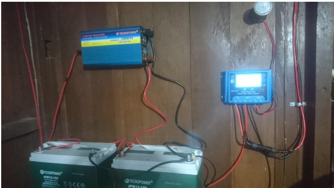
Anexo 15. Sistema solar fotovoltaico conectado y en funcionamiento.
