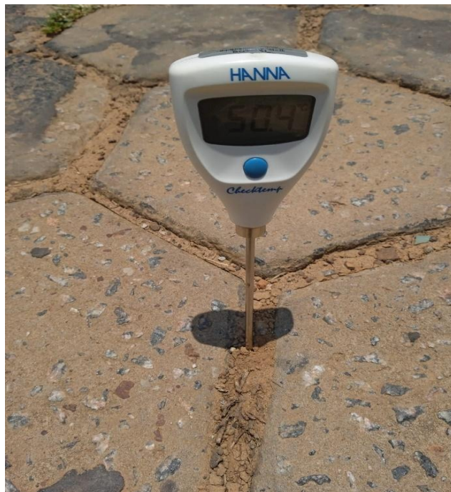
Figura 27 Medición De Temperatura Del Suelo En El Pavimento
