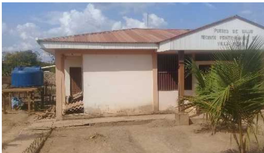
Figura 40 Tanque de 2 mil litros para el funcionamiento de puesto de salud del centro penitenciario de Villa Busch.
