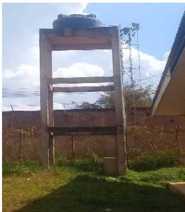
Figura 36 Tanque de 2 mil litros para las personas privadas de libertad en el centro penitenciario de Villa Busch.
