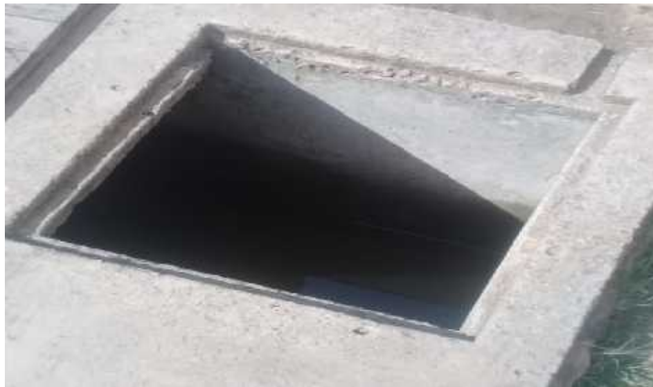
Figura 34 Tanque de agua de 2 mil litros de agua subterráneo para las personas privado de libertad.
