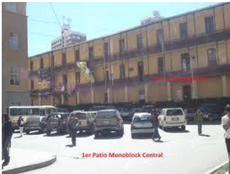
ANEXO B 15 PRIMER PATIO EDIFICIO ANTIGUO
