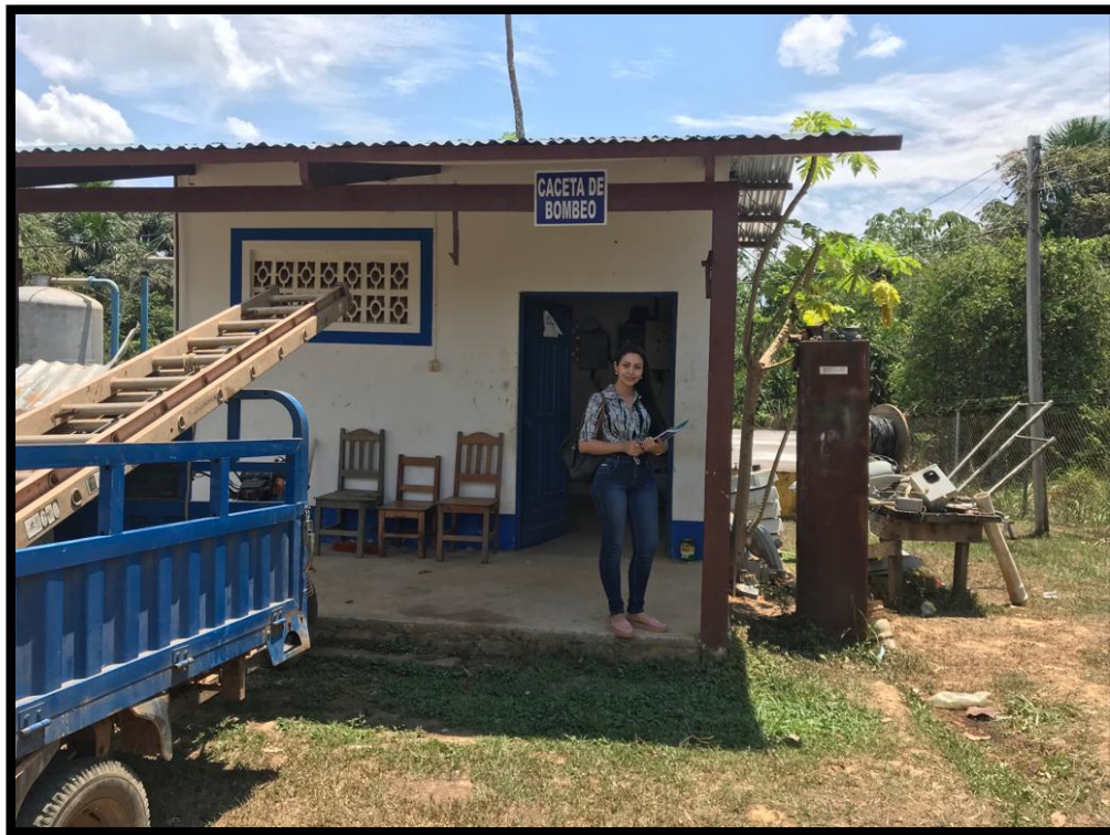
Figura 4. Anexo I. Planta de agua potable Porvenir Caseta de Bombeo
