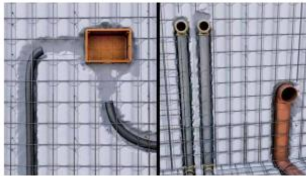
Figura 7 Contracción con fuego del poliestireno para canalización, previo al proceso de revocado
