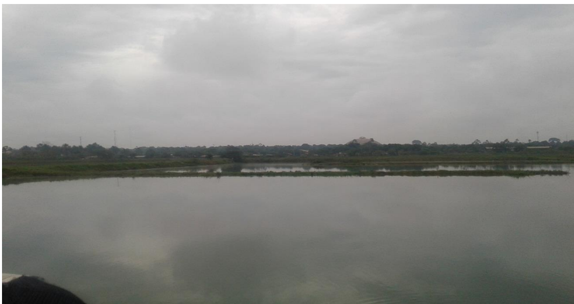
Figura 7: Planta de Tratamiento de Agua Residuales
