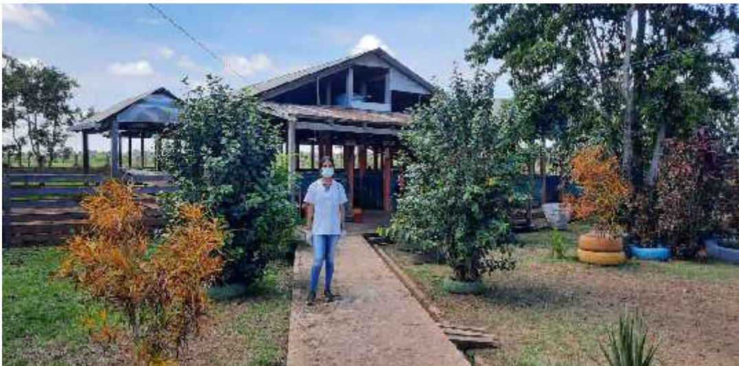
Figura 12 Fotos de frontis del Módulo Porcino
