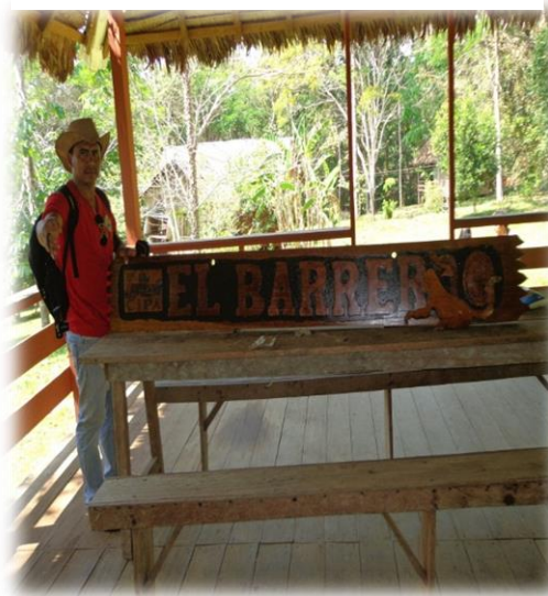
Fuente propia Comedor de la estación Biológica Tahuamanu en reparación.
