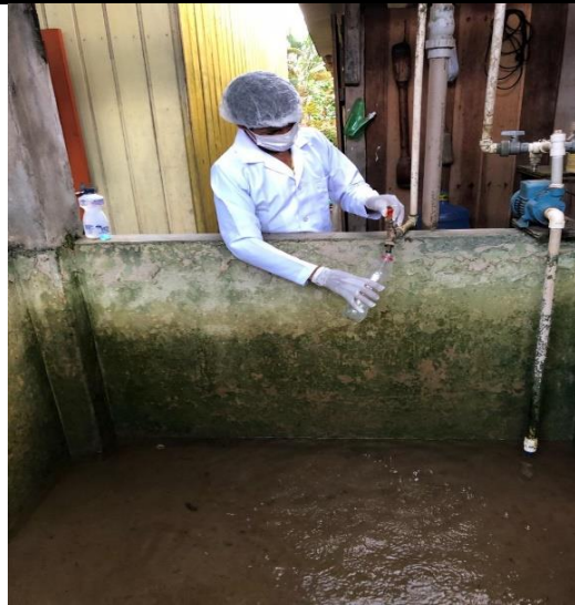
Foto 8: L 8 agua potable.
