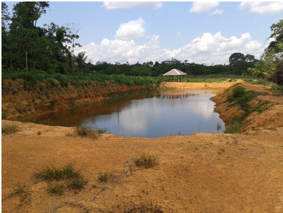
LLENADO DE LA POZA Nº1 DESPUES DEL CALEADO
