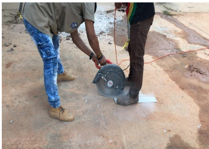
Figura. 10 Cortado de losa de hormigón armado espesor de 15 cm
