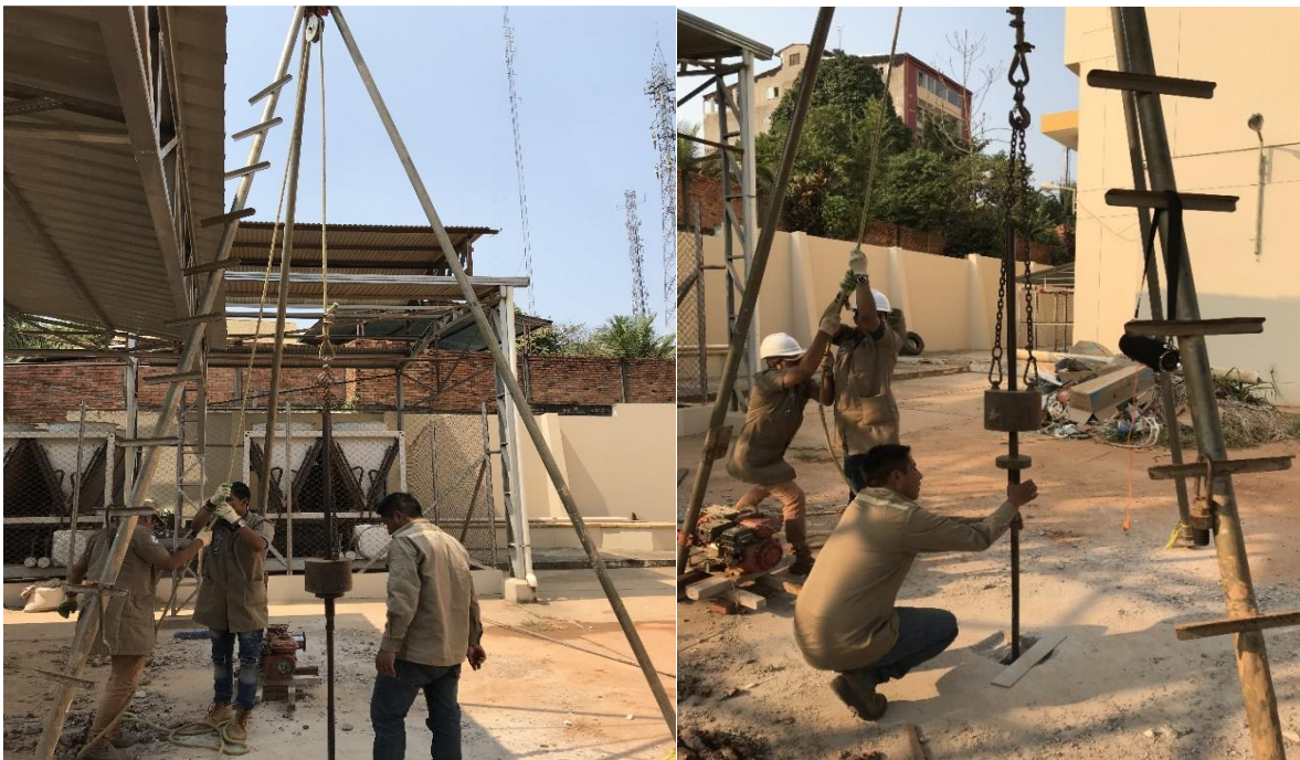
Figura 7 Vista panorámica de ensayo de SPT.
