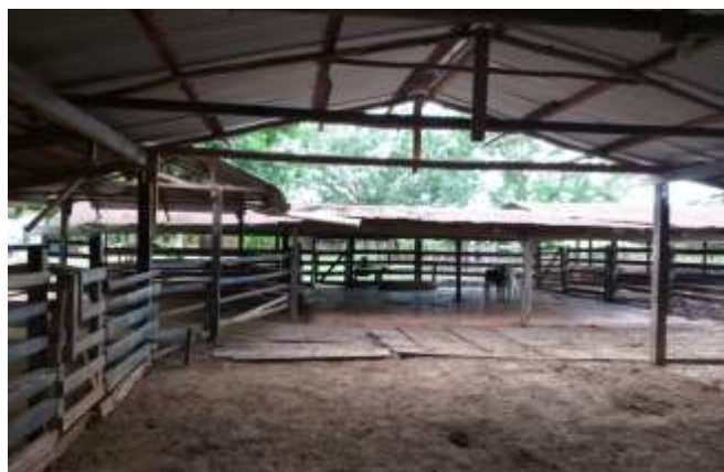
Figura 6 Foto real de la infraestructura de la lechería
