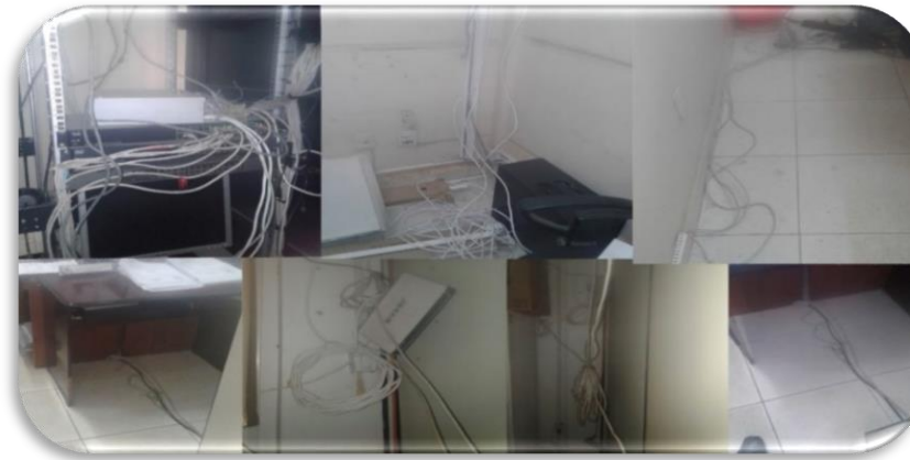
FIGURA 14: Estado de la Red de Datos de la Dirección de Información Académica inicio Fuente: Elaboración propia
