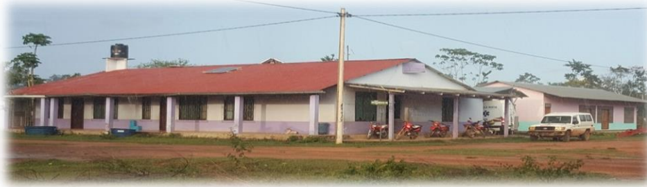
Figura. 4 Vista panorámica del Centro de Salud.
