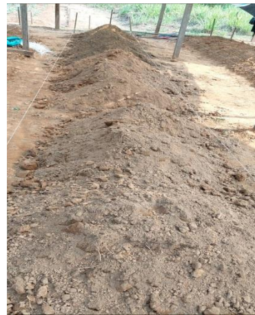
Anexo 12 Mezcla y armado de camellones. Fuente: elaboración propia.
