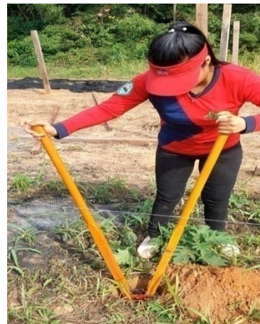
Anexo 6 Cavado y colocado de postes. Fuente: elaboración propia.
