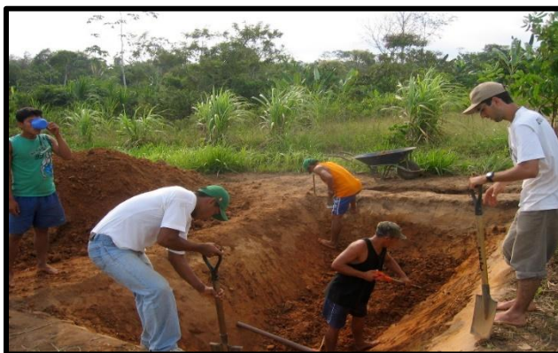
Figura 15: Elaboración de un relleno sanitario manual
