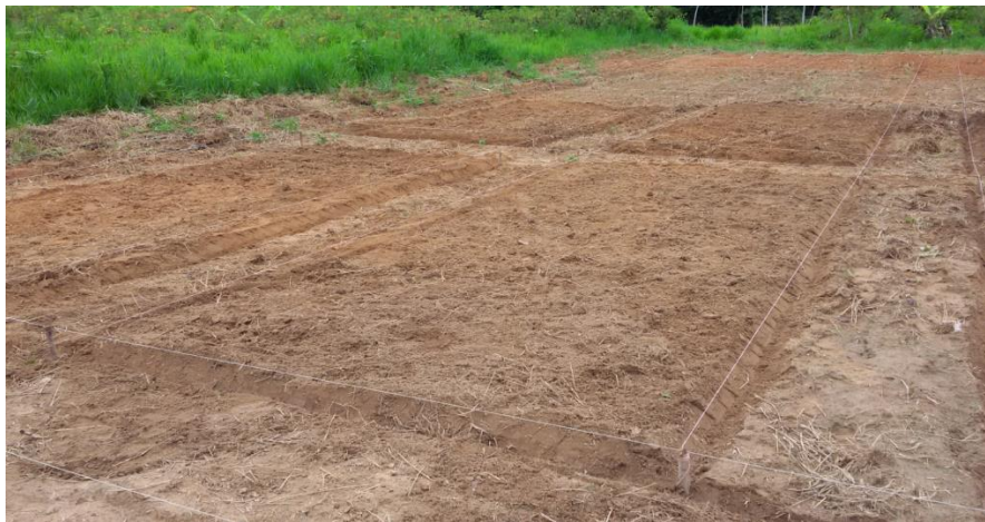
Fotografía N° 2 Preparación del terreno
