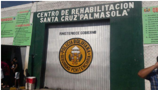
Centro de Rehabilitación Palmasola de la ciudad de Santa Cruz
